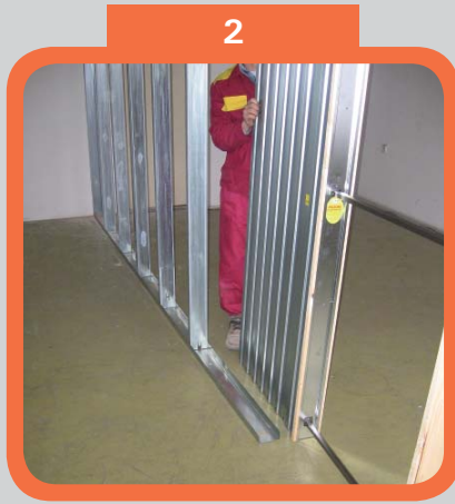
Usazení pouzdra do spodního profilu SDK
