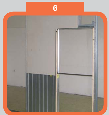
Opláštění pouzdra deskou SDK
